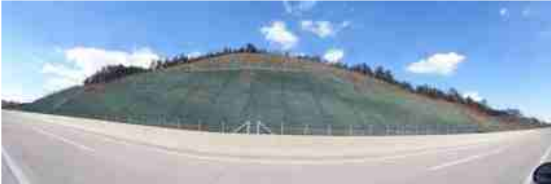
상주절토 44 (관리이정 66.378~66.678km / 8공구 STA.1+020~1+320)
