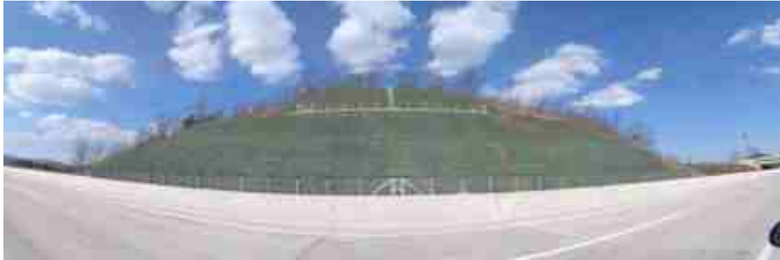
상주절토 56 (관리이정 74.962~75.098km / 8공구 STA.9+604~9+740)
