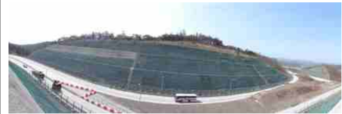
영천절토 61 (관리이정 0.320~0.537km / 8공구 화산JCT R-D 우측 STA.0+320~0+537)
